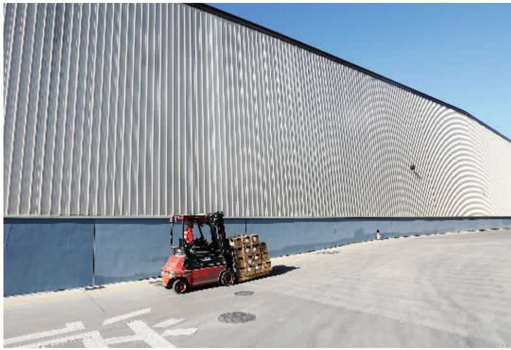
■麻涌镇京东物流仓库
